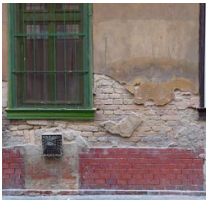
D18 - Jó állapotú nagyméretű téglafalazat a földszinten
