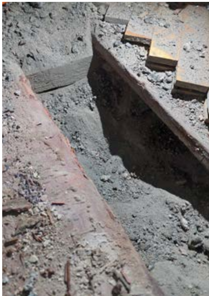
D18 - Közbenő födém feltárása
