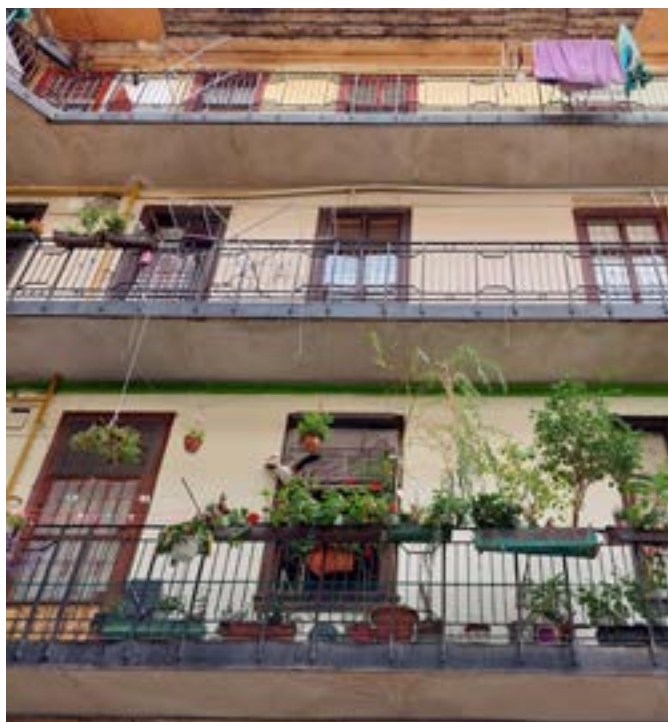
D20 - Acélgerendák között beton szerkezetű függőfolyosó, cserélt korláttal
