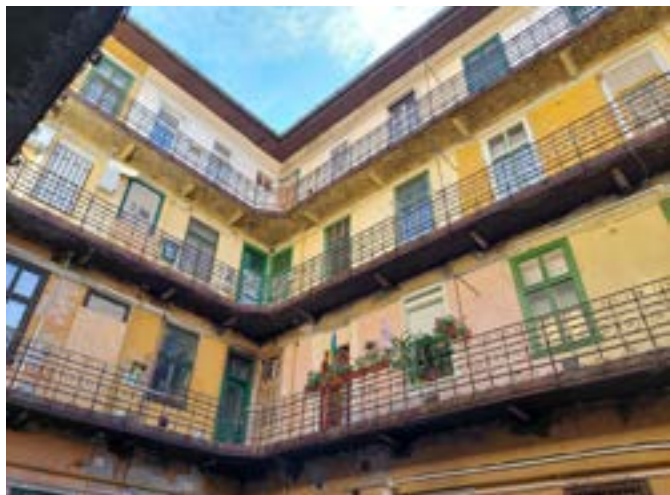
D18 - Beton szerkezetű függőfolyosó, cserélt, előregyártott beton elemekkel, eredeti korlátokkal
