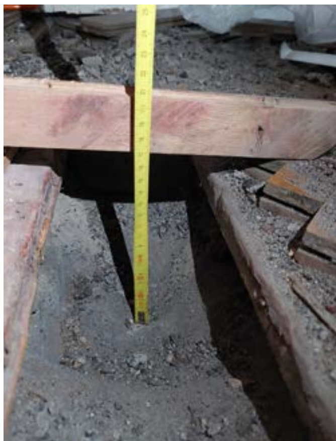
D18 - Közbenő födém feltárása
