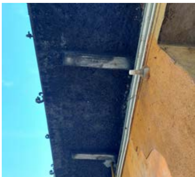
D18 - Beton szerkezetű függőfolyosó, cserélt, előregyártott beton elemekkel
