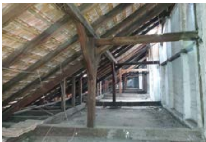
D20 - Jó állapotú fa fedélszerkezet
